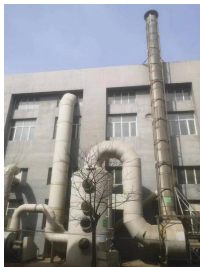
A3 车间 1 号喷淋塔（TA008） A3 车间 1 号排气筒（DA008）
